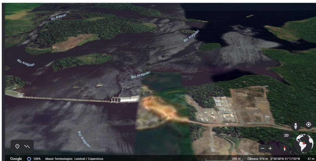
Imagem 8- Barragem da usina hidrelétrica Cachoeira Caldeirão, Amapá, Brasil
