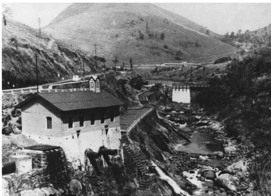
Imagem 1 – Unidade de geração de energia Marmelos, em Minas Gerais
